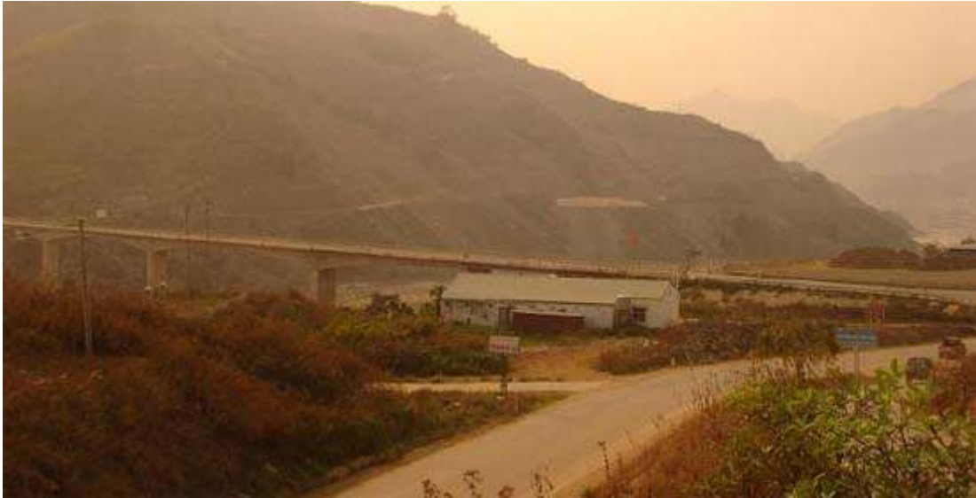
Cầu Mường La phía hạ lưu đập
