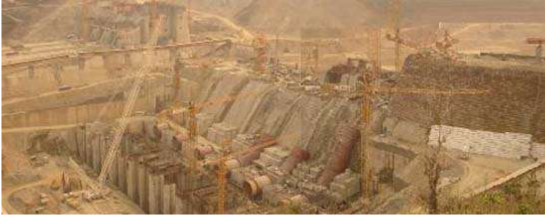
Thi công đập chính tháng 3/2009
