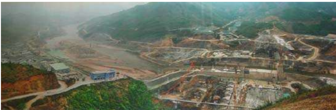
Toàn cảnh công trường năm ngoái, tháng 3/2008
