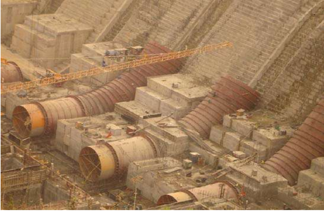
công phần đập tràn phía bờ phải Thi công đường ống thép dẫn nước vào nhà máy thủy điện
