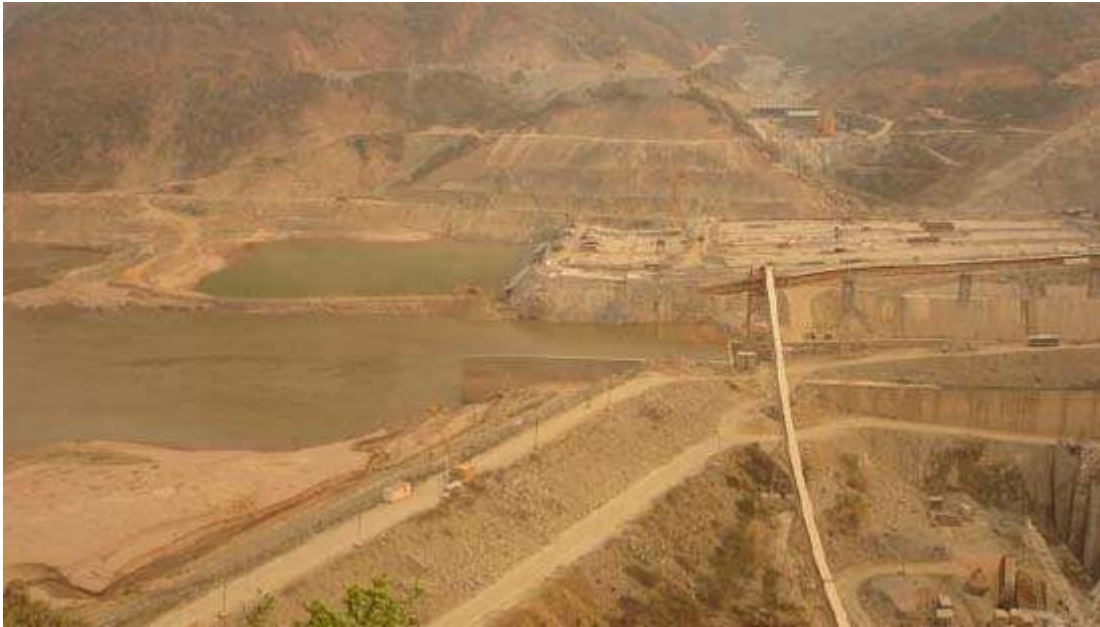
Đê quai hạ lưu vẫn dẫn dòng qua đập
