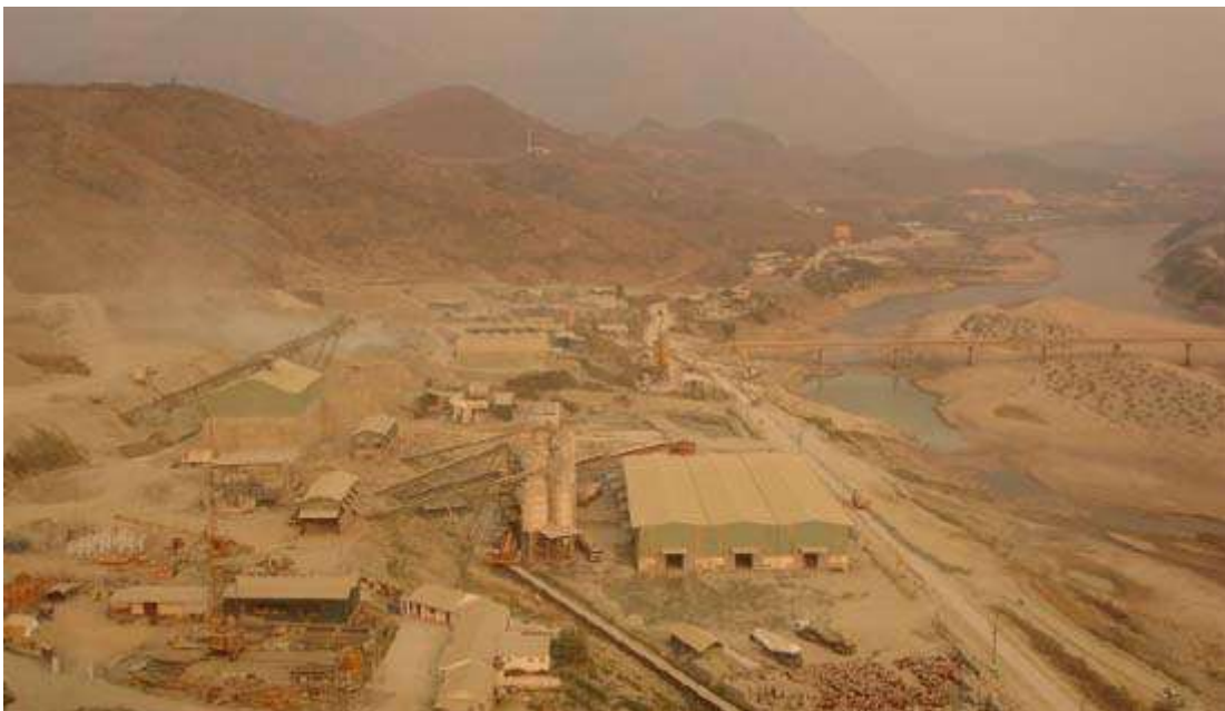
Kho bãi vật liệu bên bờ trái ở hạ lưu đập
